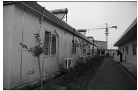
图 1 施工营地照片
