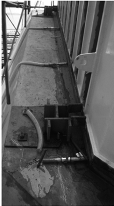
图10 箱外排气孔浆液排出
