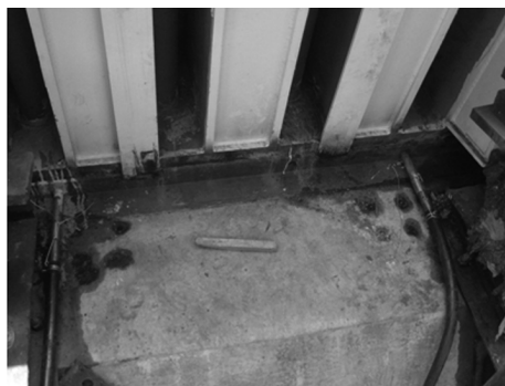
图7 压浆管连接
