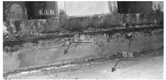
图11 压浆后表面情况
