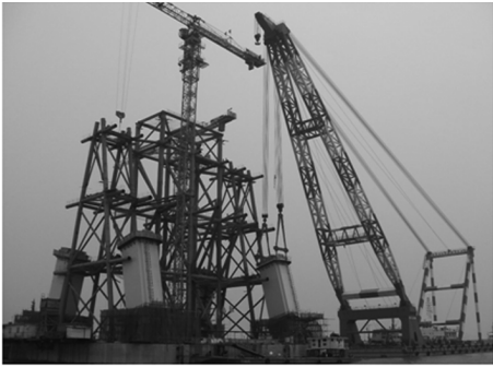
图 11 钢塔大节段吊装
