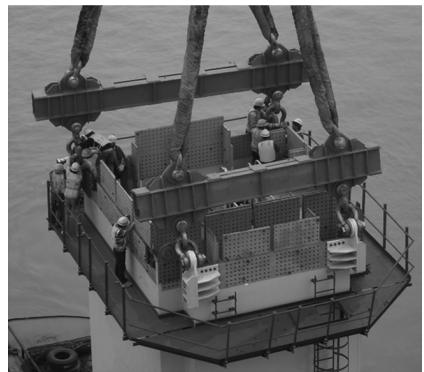
图6 临时工作平台示意图 Fig. 6 Temporary work platform
