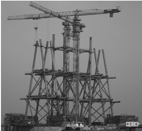
图5 大节段定位支架
