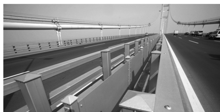
图3 润扬长江大桥的中央稳定板
