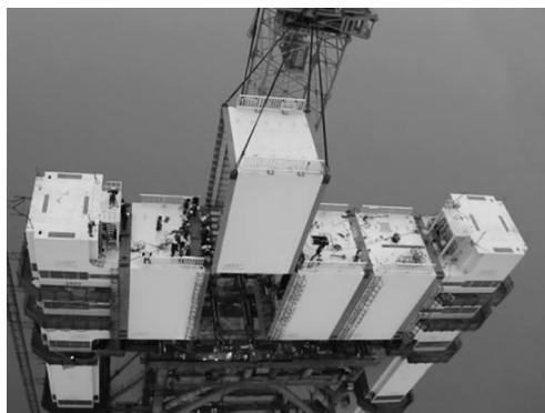
图 7 横梁分节段安装
