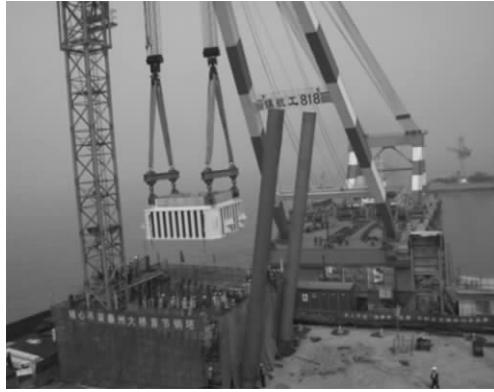
图 5 钢塔首节段安装
