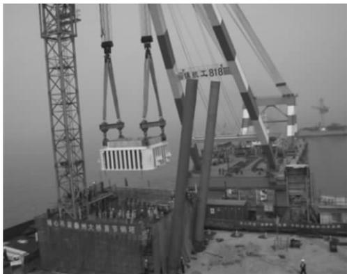
图 5 钢塔首节段安装
