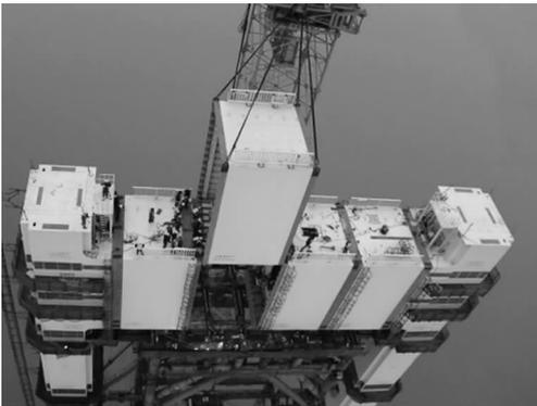
图 7 横梁分节段安装
