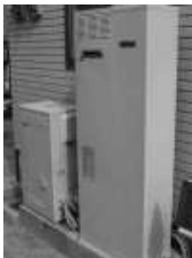
图 7 利用 Kyocera 阳极支撑扁管电池制造的 700 W SOFC CHP 单元(左:SOFC 系统;右:热水箱)
