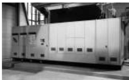
图 21 100 kW SOFC 发电机系统
