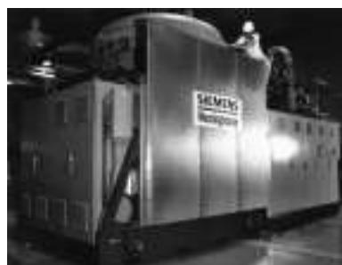
图22 200 kW加压式混合SOFC/微型汽轮机发电机
