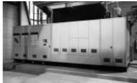
图21 100 kW SOFC发电机系统
