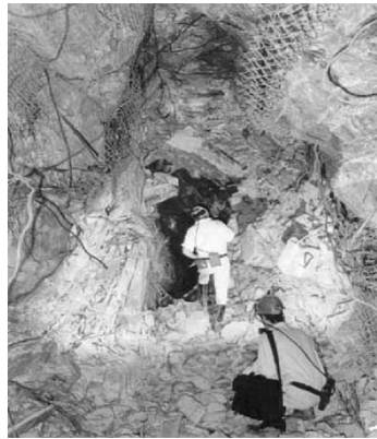
图4 南非 Hartebeestfontein 金矿硬岩巷道围岩的大变形 [15]
