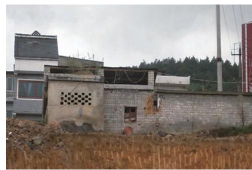
图3 软弱夹层导致冲炮而引起泥块砸破墙体
