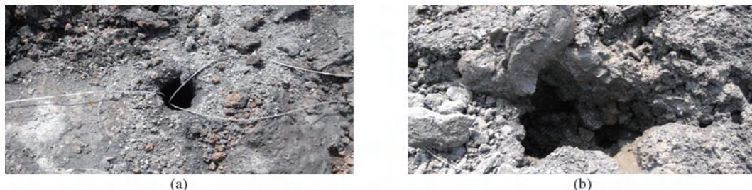
图2 软弱夹层导致的冲炮
