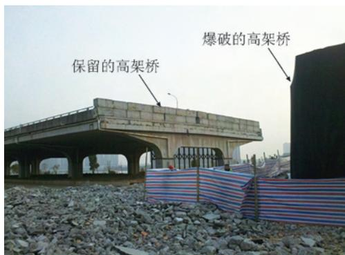
图9 保留高架桥和爆破高架桥
