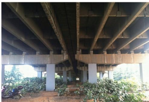
图2 T型梁结构图及图片(单位:m)
