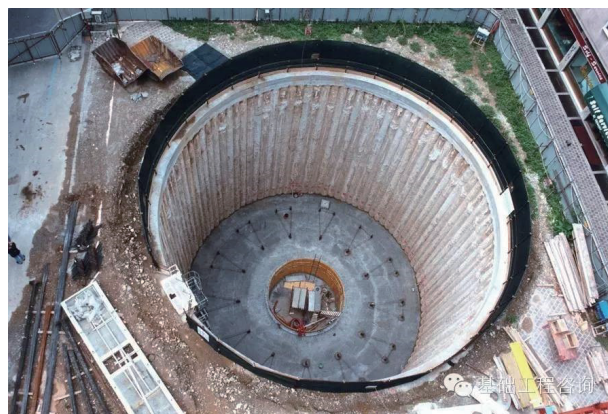
图 12 咬合桩形成的闭合圆筒结构
