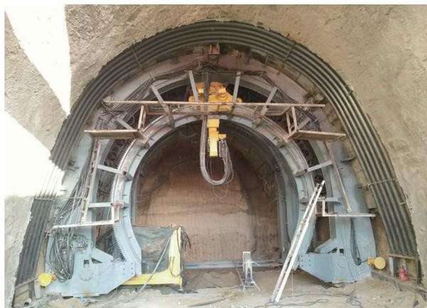
图4 移动支护结构法现场施工图
