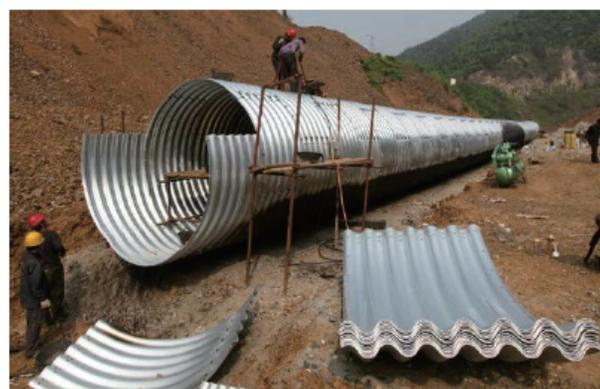
图5 钢波纹板拼装示意图
