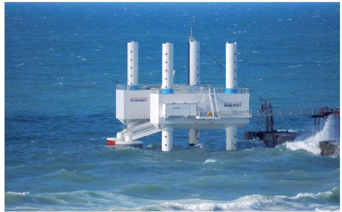
图 10. 一个 1:2 的自升式装置通过浮点吸收器从海浪中提取能量。（Wave Star 公司批准）
