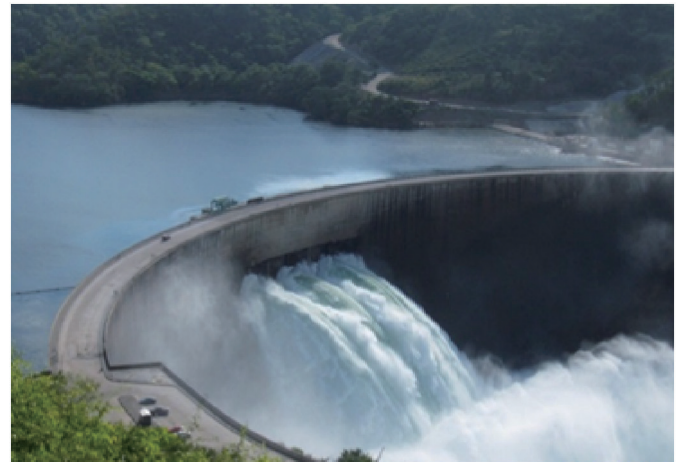
图6. 2010年4月卡里巴大坝间隔开启3孔泄洪的下游视图(B. Goguel提供)。
