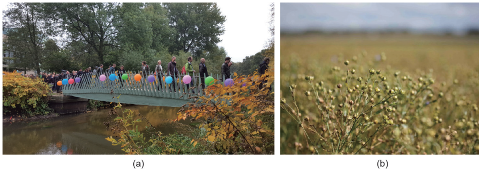
图21. 亚麻纤维、生物树脂、聚乳酸泡沫以及天然软木被用于建造这座位于埃因霍温市的生物复合人行桥。(a)埃因霍温市生物复合人行桥通行仪式(笔者版权所有，2016年10月27日摄)；(b)可提取亚麻纤维的亚麻植物。
