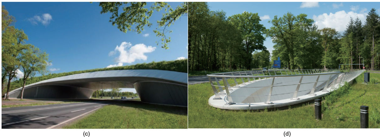
图9. 荷兰部分具有纤维增强复合材料边缘部件的项目。(a)哈勒姆的瓦德波尔德跨线桥; (b)赞斯塔德的朱莉安娜女王桥上的边缘部件; (c, d)里森威尔登的野生动物横道和行人隧道(荷兰Royal Haskoning DHV集团, 2007, 2013, 2013)。
