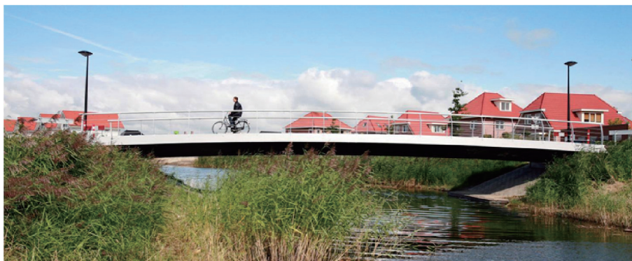
图7. 旨在建造一体化桥梁结构的工程专利技术(Peeters, 2011年摄)。
