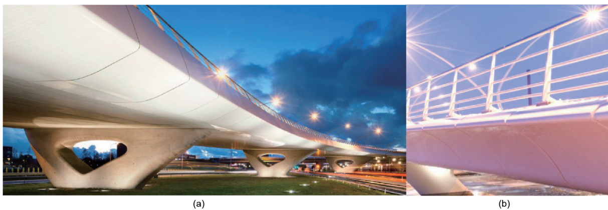
图8. (a)安装和(b)瓦德波尔德跨线桥中边缘部件的最终装配。
