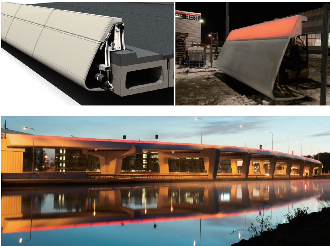
图10. 高速公路N201高架桥面板上安装的红色亮灯。
