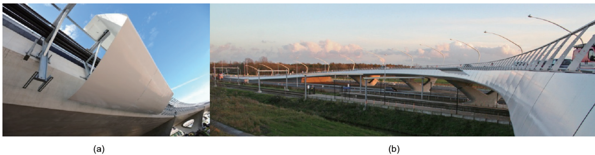
图8. (a)安装和(b)瓦德波尔德跨线桥中边缘部件的最终装配。
