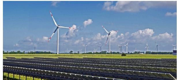
图1. 国际绿色氢气项目计划建立两处可再生能源发电厂,为电解提供动力。例如,位于西澳大利亚州的亚洲可再生能源中心(Asian Renewable Energy Hub)将包括一座可在白天收集太阳能的光伏农场以及在多风的夜晚进行能量收集的风电机组,上图为该中心的设想图。可再生能源的组合使用可为绿色氢气生产提供持续的能源,从而摆脱对化石燃料的依赖。来源:Pixnio(CC0)。
