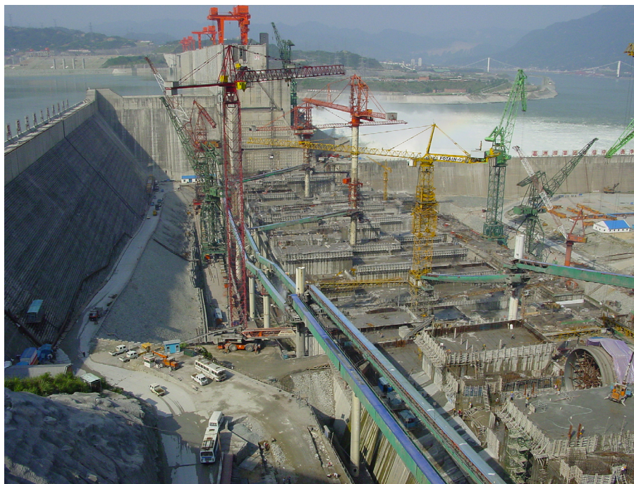
图2. 三期大坝施工现场
