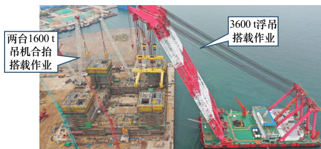
图9 海陆同时吊装搭载作业
