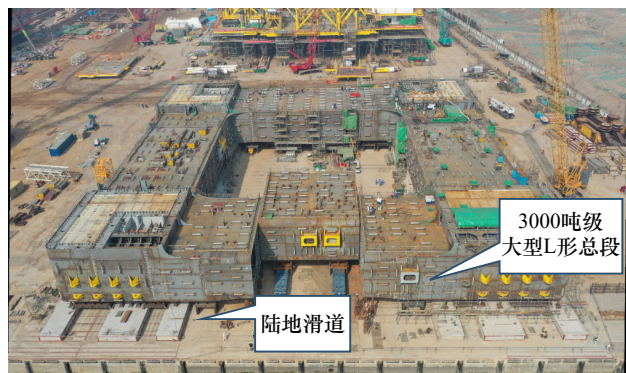
图8 大型L形总段及滑道搭载
