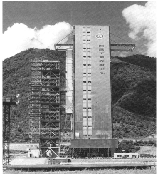
图 3 西昌卫星发射中心第二发射工位 Fig.3 2 # launch complex, Xichang Satellite Launch Centre
